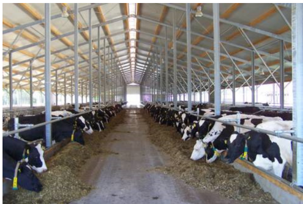
Abbildung 14: Stallneubau mit Dacheindeckung aus Sandwichelementen
