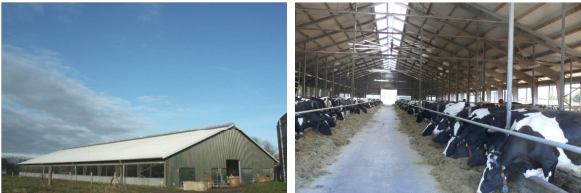
Abbildung 11: Außen- und Innenansicht des untersuchten Milchviehstalles
