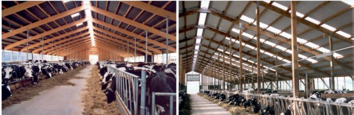
Abbildung 19: Empfohlene Anordnung von Lichtplatten (links) und ungünstige Anordnung (rechts)
